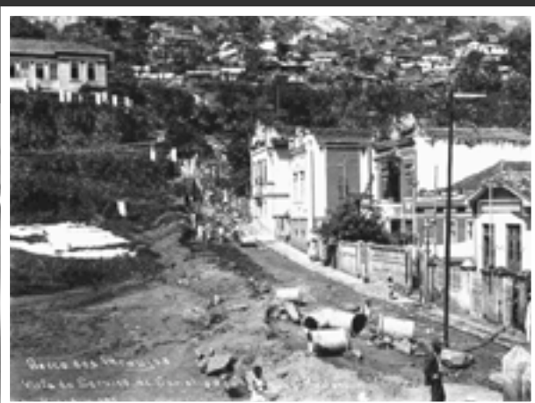
Beco dos Arraújos em obras, em 1930. Ao fundo, favela da Tijuca Acervo AGERJ
